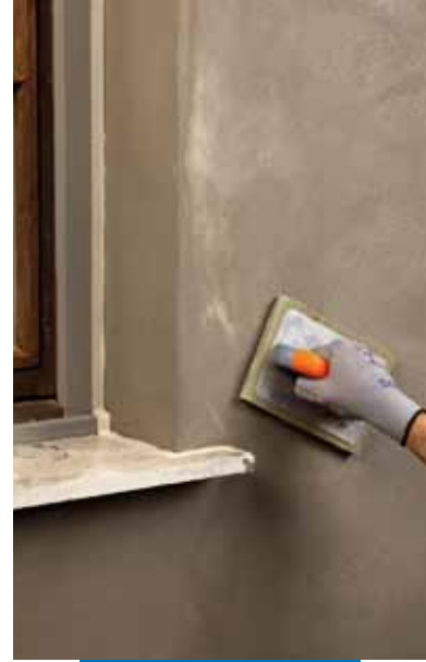
Planitop 210 yüzeyinin bitirilmesi
